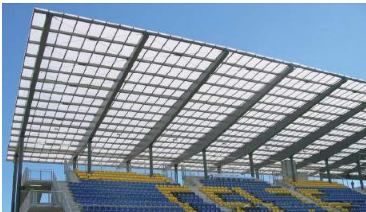
Nadstrešnica stadion Celje, večslojne polikarbonatne plošče
